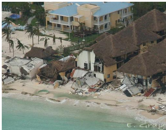
Figura 9 –Efectos de oleaje de Huracán Wilma sobre hotel en Playa del Carmen. (Foto: E. Gray)
